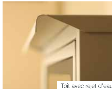
Toit avec rejet d'eau
